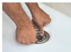
8 Sifoniereinsatz bis zum Anschlag hineindrücken. Bügel wieder nach unten legen.
