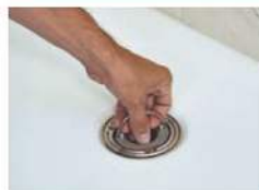
7 Sifoniereinsatz einsetzen
