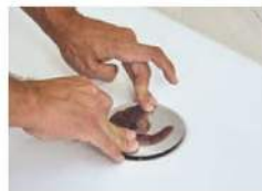
9 Sifonabdeckung einsetzen
