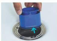
5 Sifontrennwand mit Dichtring nach unten einfügen.
