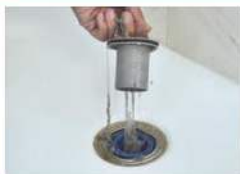
2 Sifoniereinsatz am Bügel herausziehen
